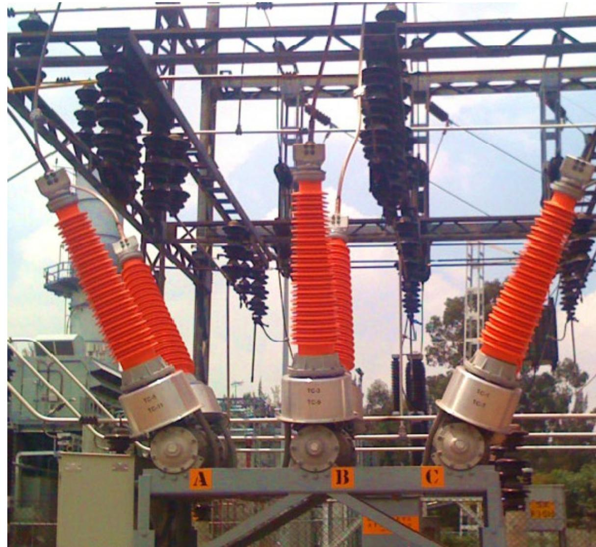
Recubrimiento elastomérico de silicon para aisladores de cualquier composición
